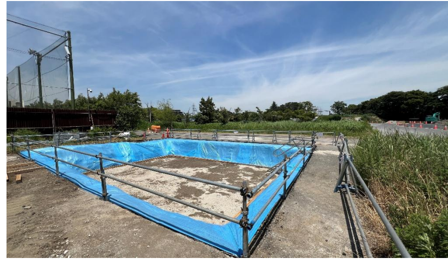
ゾーン⑥便所① 土工事
