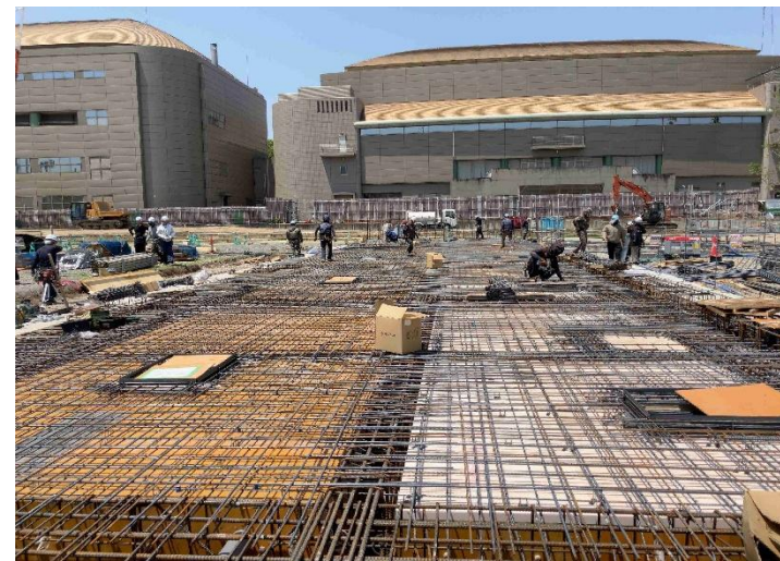
観客スタンド1階床躯体工事 (新)等々力陸上競技場建設工事
