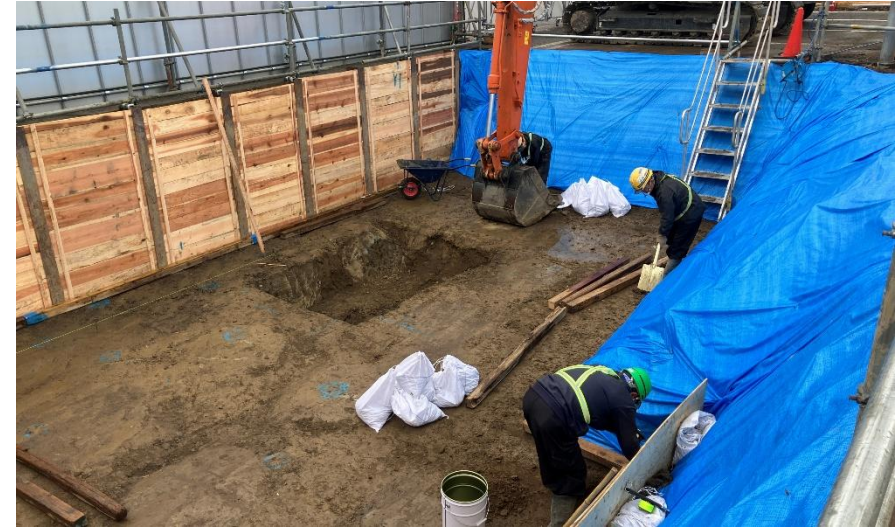
ゾーン① 便所② 土工事
