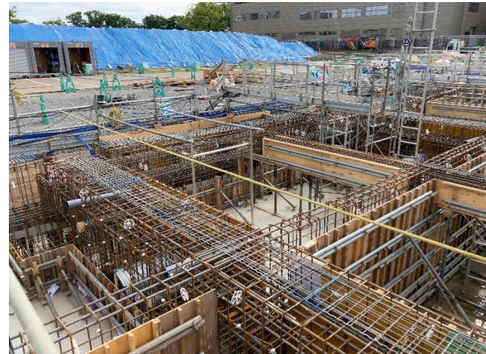
観客スタンド基礎躯体工事
