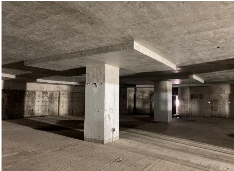
4月 内装解体状況(1F展示室)
