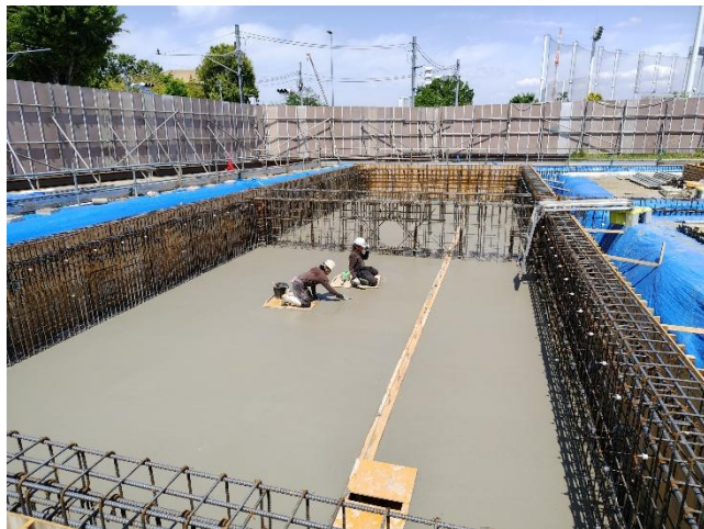
4/20~5/29 コンクリート工事
