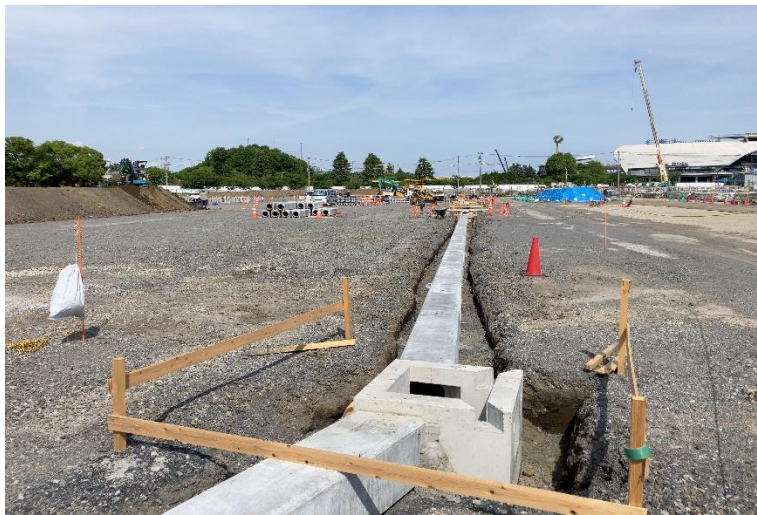
トラックフィールド排水工 事
