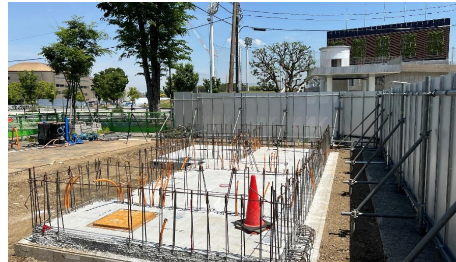
ゾーン① 便所② 地下躯体完了
