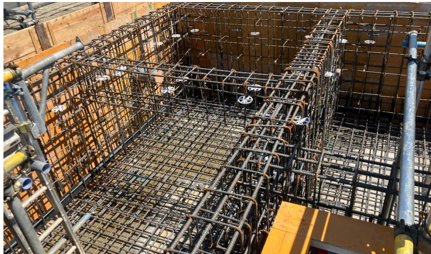
ゾーン① 便所② 地下躯体工事
