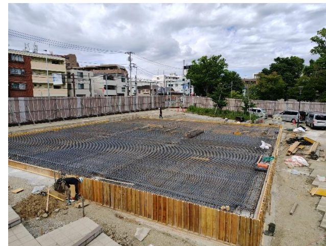
3/25~5/29 鉄筋型枠工事
