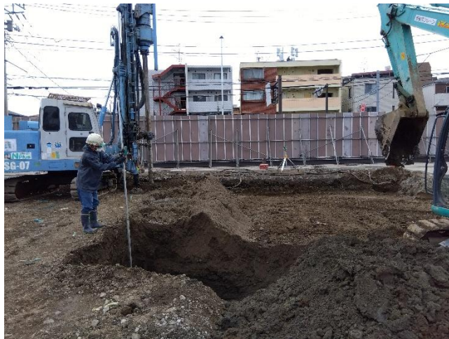
2/13~3/13 地盤改良工事
