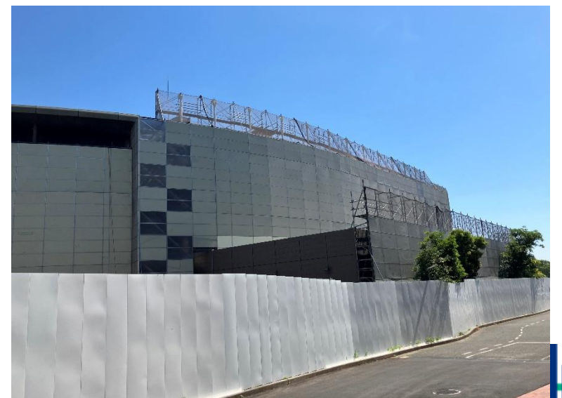
5月下旬 外部養生足場状況(南側)
