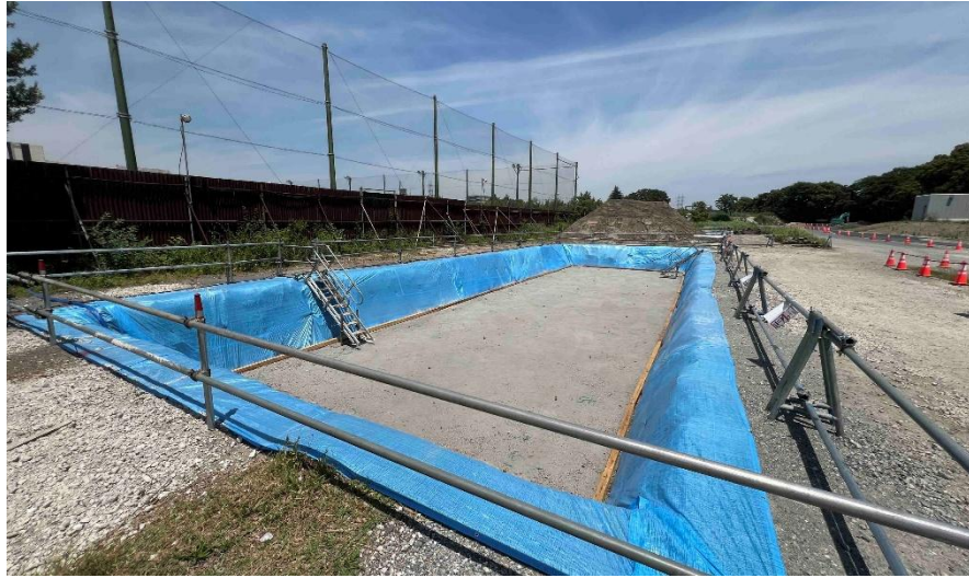
ゾーン⑥サッカーコートクラブハウス 土工事
