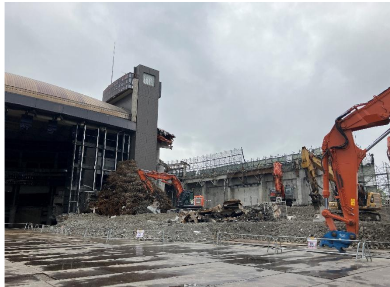
5月下旬 建屋解体状況
