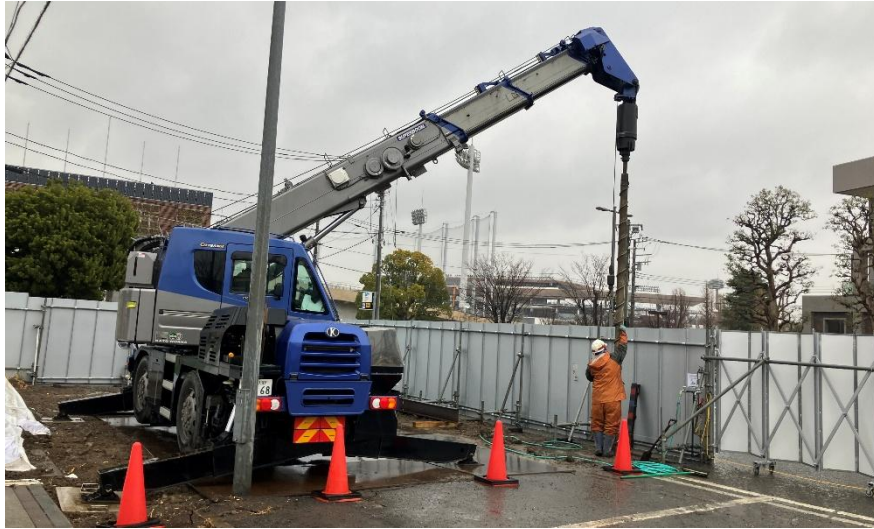
ゾーン① 便所② 山留工事
