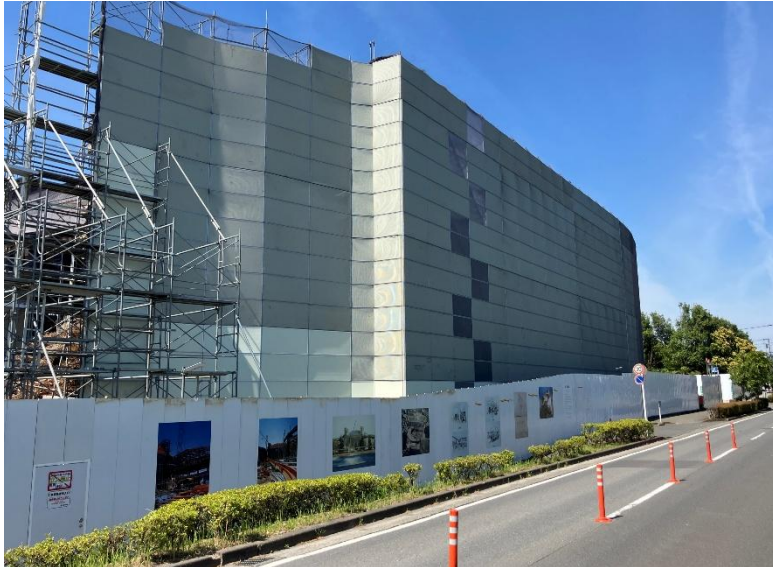
5月下旬 外部養生足場状況(北側)
