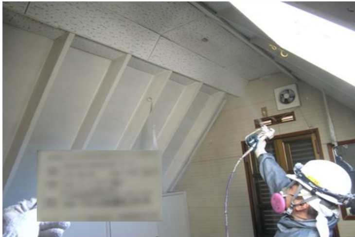
【石綿飛散抑制剤による湿潤化状況】
