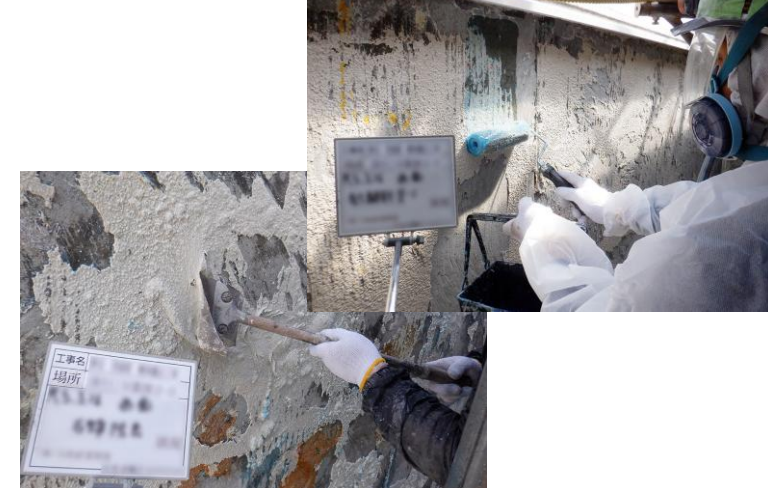
【剥離剤併用手工具ケレン工法】
